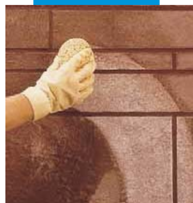
Čištění a konečná úprava spár houbou
