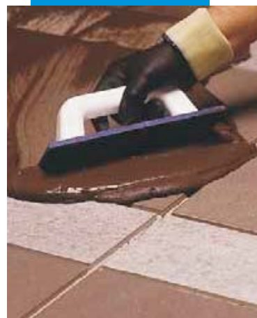
Spárování dlažby Ultracolem Plus pomocí gumového hladítka
