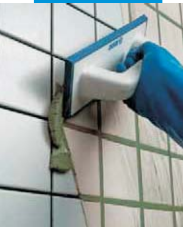
Spárování obkladů Ultracolem Plus spárovací gumou
