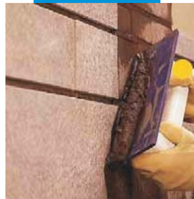
Spárování obkladů stěn Ultracolorom Plus gumovou stěrkou
