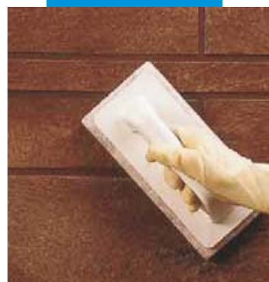
Čištění spár Scotch-Brite® (částečné zatvrdlý tmel)
