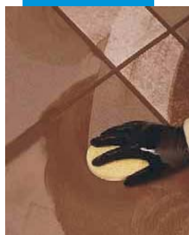
Čištění a konečná úprava spár houbou
