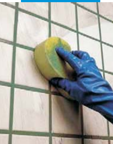
Konečná úprava obkladů pomocí houby
